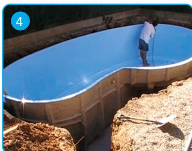
Puesta a nivel Levelling
