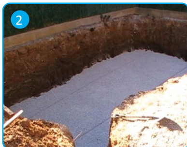
Preparación del terreno Ground preparing
